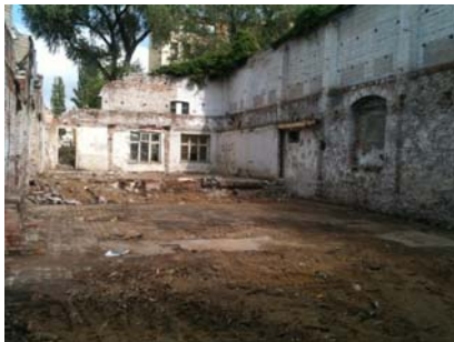
Ruine vor dem Aufbau
