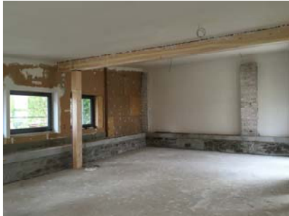
UdiSUN® im Deckenbereich verspachtelt
