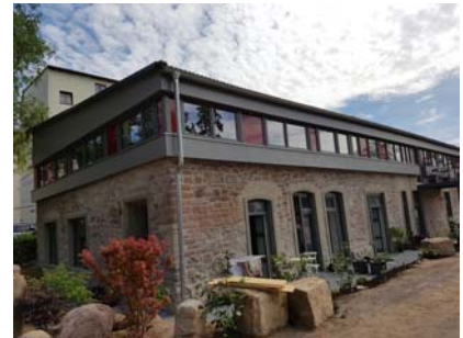
Außenansicht nach Fertigstellung
